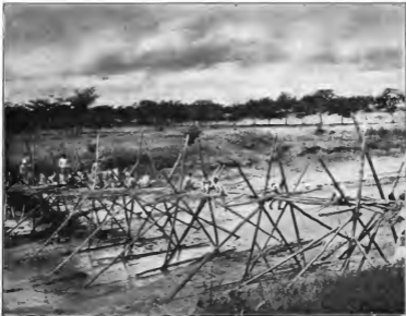
Brückenbau bei Trockenzeit.
